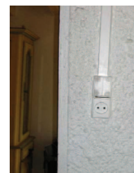
Réseau électrique descendant hors d'eau. (Source : EPTB Saône-Doubs)
