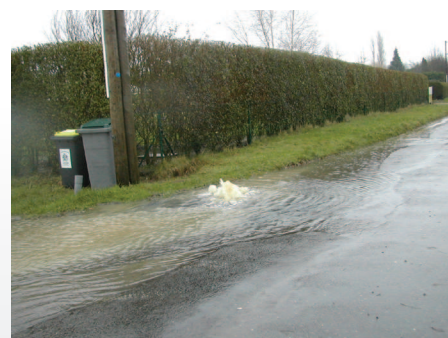
Saturation du réseau d'assainissement pluvial Octeville-sur-Mer – 14 février 2007 (Source : SMBV Pointe de Caux)
