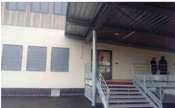
L'annexe du bâtiment n'a pas été bâtie à même le sol, on peut voir ici la surélévation à gauche, ainsi que l'accès au premier niveau qui pourra servir d'entrée à l'école refuge en cas d'inondations. PHOTOS A-L.C
