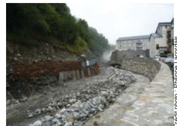
Barèges, août 2014, travaux dans le Bastan bien avancés.
